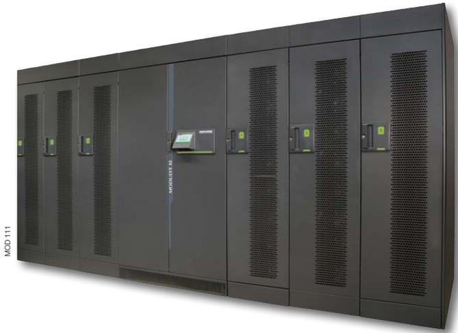
MODULYS XL ist eine modulare USV mit 200-kW-Leistungsmodulen. Die Leistung einer einzelnen USV lässt sich auf bis zu 1200 kW erhöhen und die Anlage kann bis zu 4 parallel geschaltete Einheiten enthalten.
